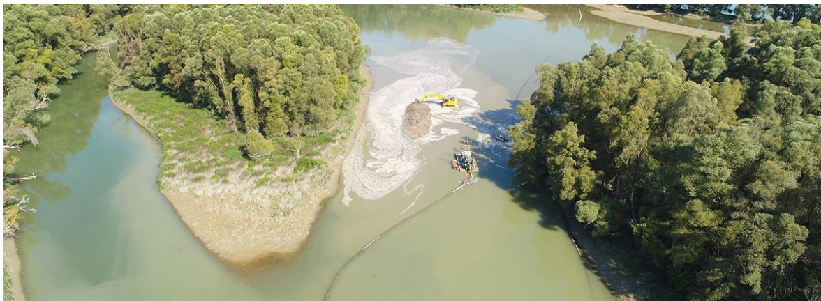
1. kép: Hidromechanizációs kotrási munkálatok az Erebe-szigetek mellékágrendszerében Forrás: Fertő-Hanság Nemzeti Park Igazgatóság
